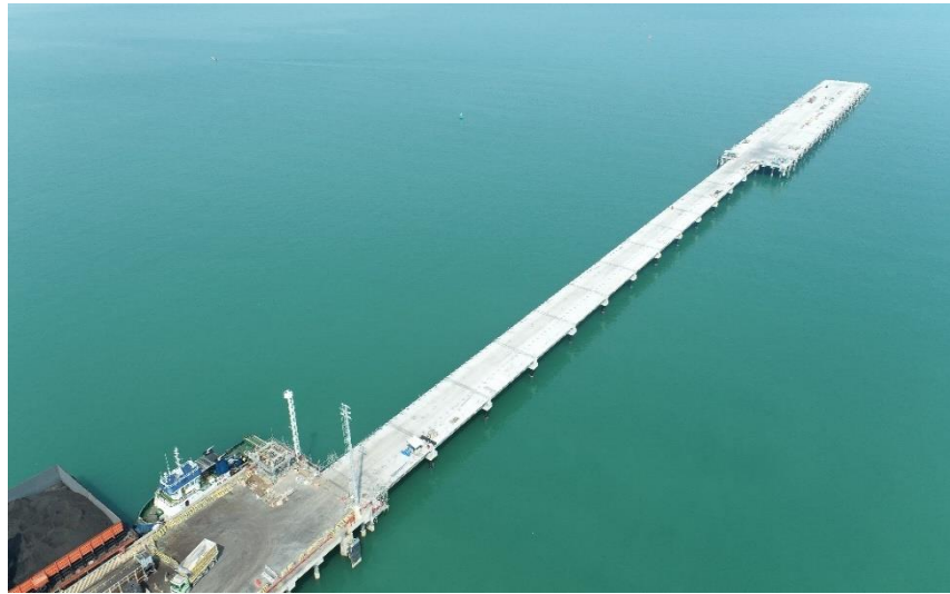
Gambar I. 1 Foto dermaga dan trestle yang baru Sumber : Dokumentasi drone PT Hutama Karya
