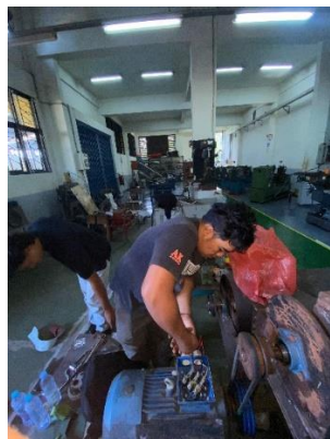
Gambar pemasangan kabel motor listrik
