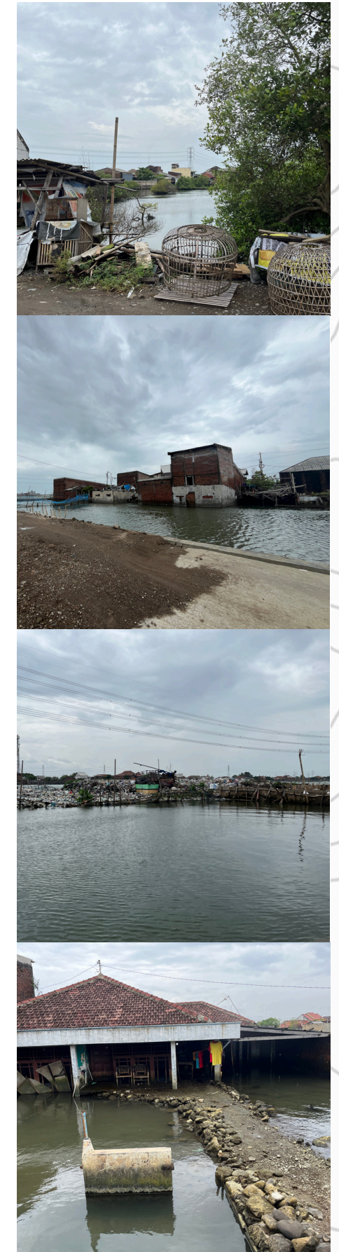
Gambar 1.4. Desa Sriwulan Banjir Sumber: Dokumentasi Pribadi, 2025
