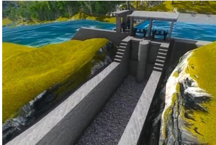
Gambar 2.6 Bangunan Pengambil air (Intake)
