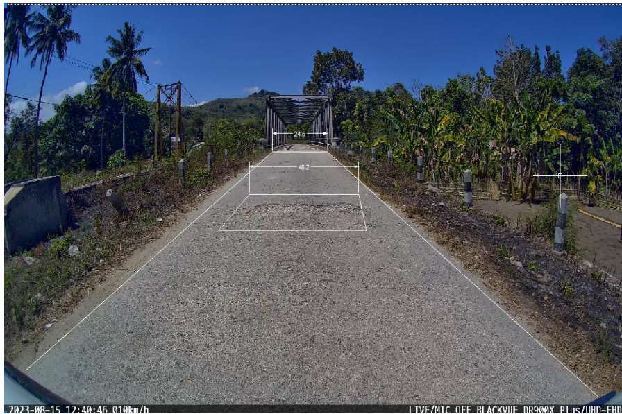
Gambar 3. 8 Plot tampilan kerusakan lubang dari aplikasi BlackVue menggunakan Autocad
