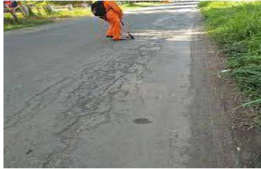
**Gambar 2.7** Retak Pinggir (Edge Cracking)
