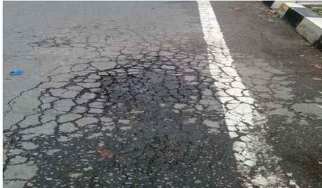
**Gambar 2.4** Retak Kulit Buaya (*Alligator Crack*)
