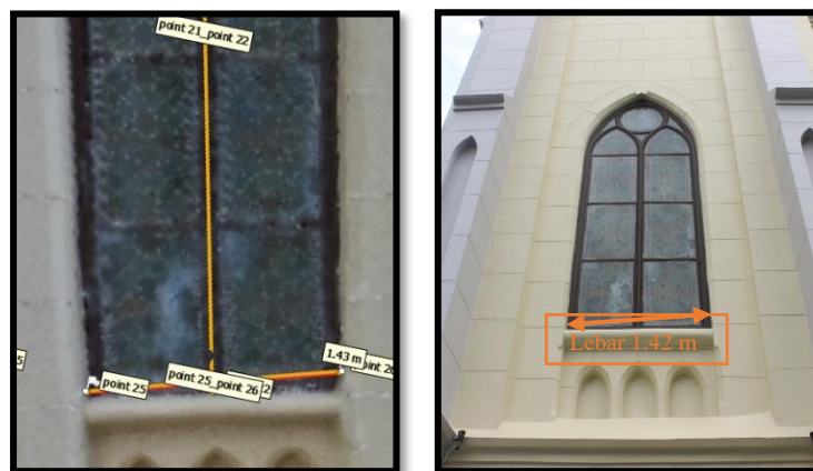
Gambar 4. 26 Jarak pada Orthophoto dan Jarak Dilapangan
