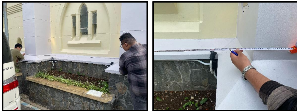
Gambar 4. 22 Fasad 6 Bangunan Kanan
