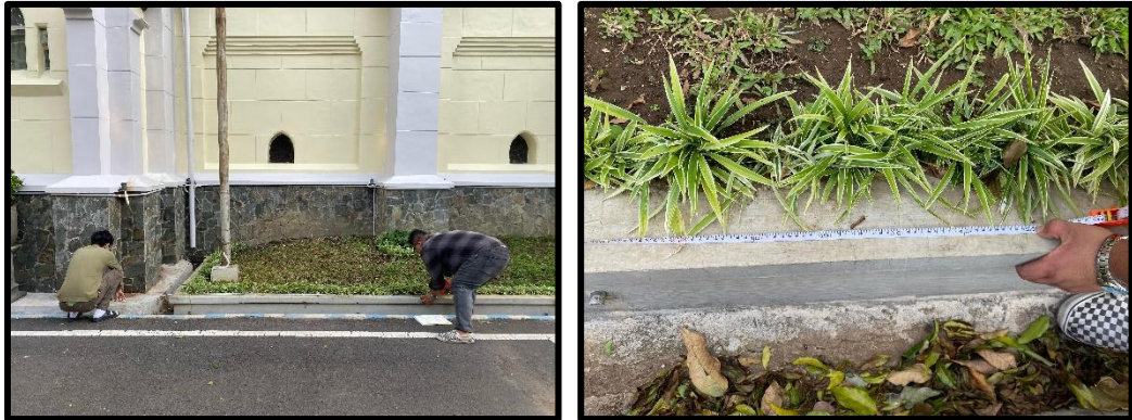
Gambar 4. 18 Fasad 3 Bangunan Kanan
