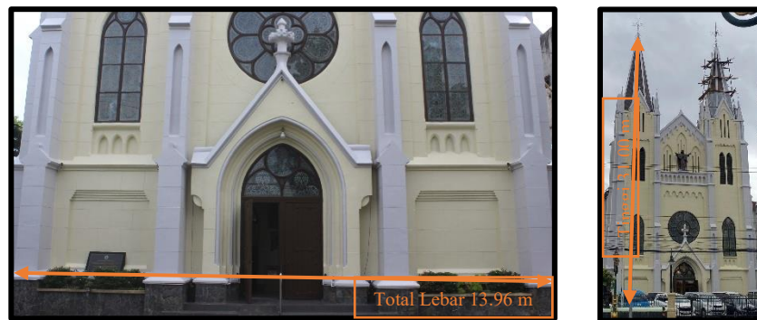
Gambar 4. 10 Fasad Bangunan Utama Menara depan
