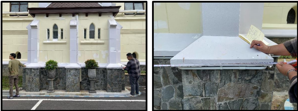
Gambar 4. 20 Fasad 5 Bangunan Kanan
