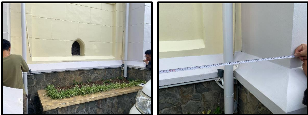
Gambar 4. 21 Fasad 6 Bangunan Kanan
