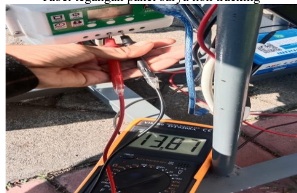
Gambar 4.3. Pengukuran panel non tracking dari SCC
