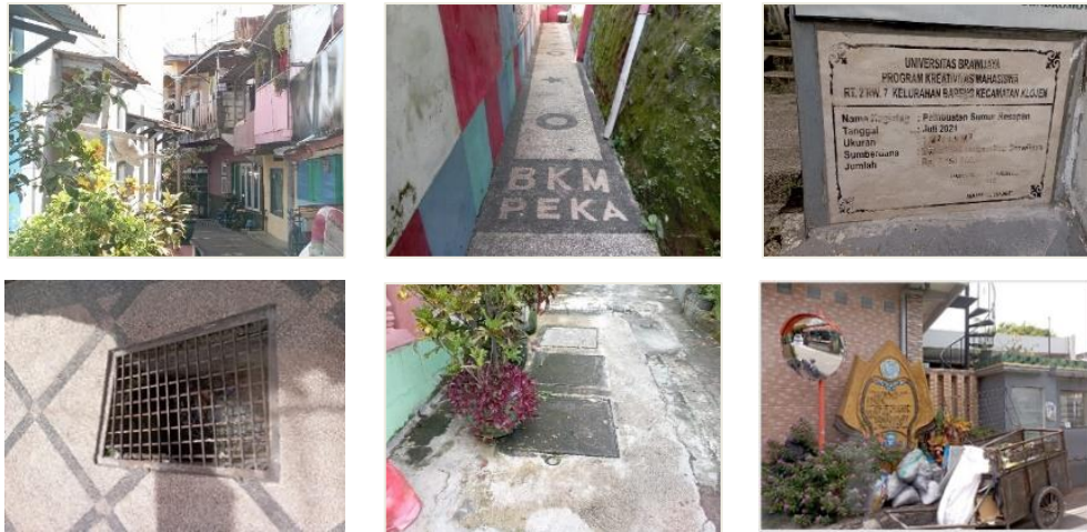
Gambar 6 Kondisi Infrastruktur Permukiman RW 08
