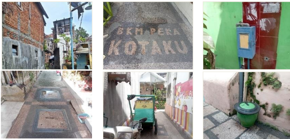
Gambar 4 Kondisi Infrastruktur Permukiman RW 03
