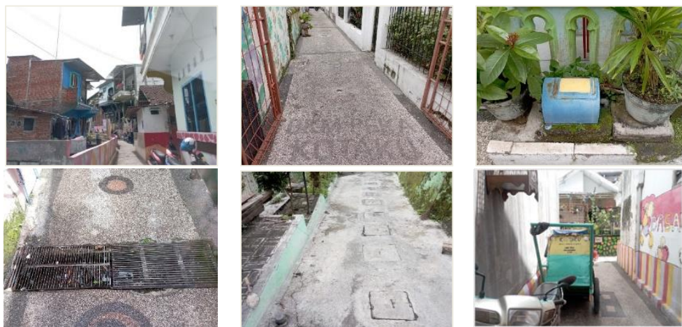
Gambar 5 Kondisi Infrastruktur Permukiman RW 07
