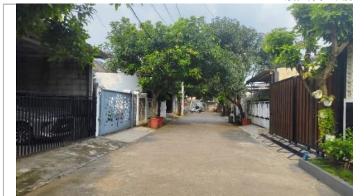
Gambar 9 Kondisi Jalan di Perumahan Permata Green Depok
