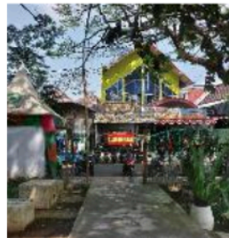
Gambar 4. Pintu Masuk Arah Barat (Sumber: Penulis,2023)
