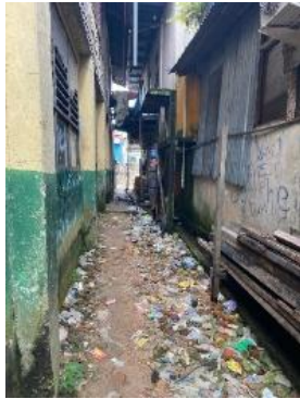
Gambar Kondisi Jaringan Jalan Pasar Baru, Kelurahan Malabutor
