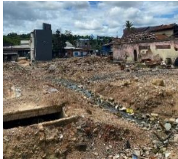
Gambar Kondisi Permukiman Pasar Baru Setelah Terjadi Kebakaran
