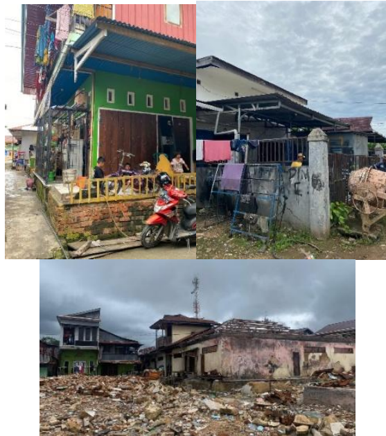
Gambar 4 2 Kondisi Bangunan Pasar Baru, Kelurahan Malabutor
