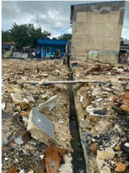
Gambar 4 1 Kondisi Permukiman Pasar Baru Setelah Terjadi Kebakaran
