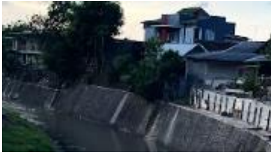
Gambar 3. 3 Kondisi Eksisting Permukiman Sumber : Hasil Observasi, 2023
