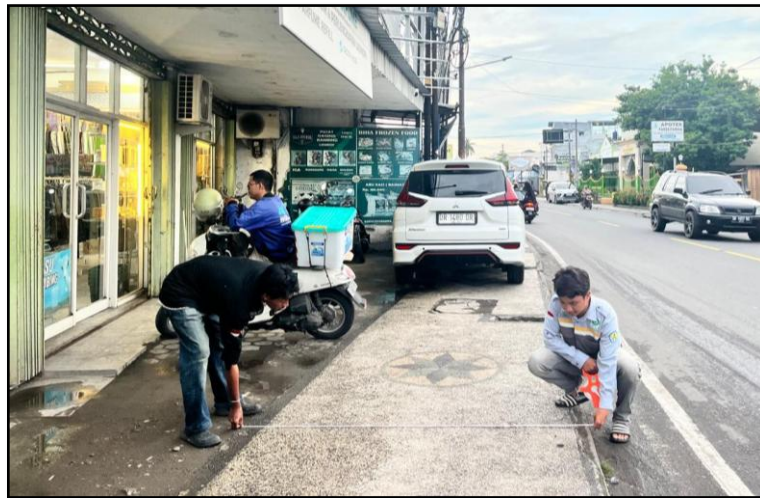
Lampiran 7. Dokumentasi Pengukuran Lebar Trotoar Pendekat Selatan Jl. Saleh Sungkar 1 Simpang Kebon Roek, Kota Mataram
