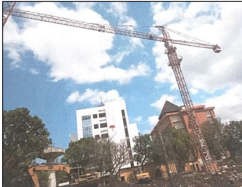
Gambar 1. 1 Tower Crane di Lapangan
