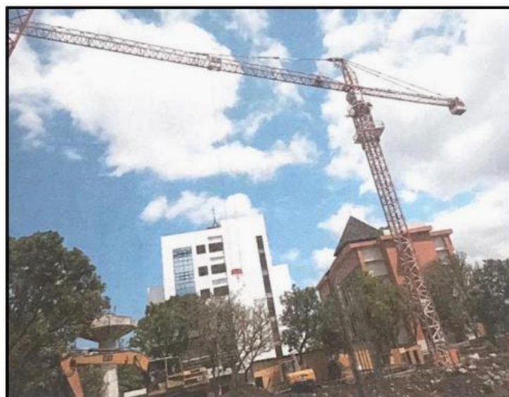
Gambar 1. Pemasangan Tower Crane di Lapangan.
