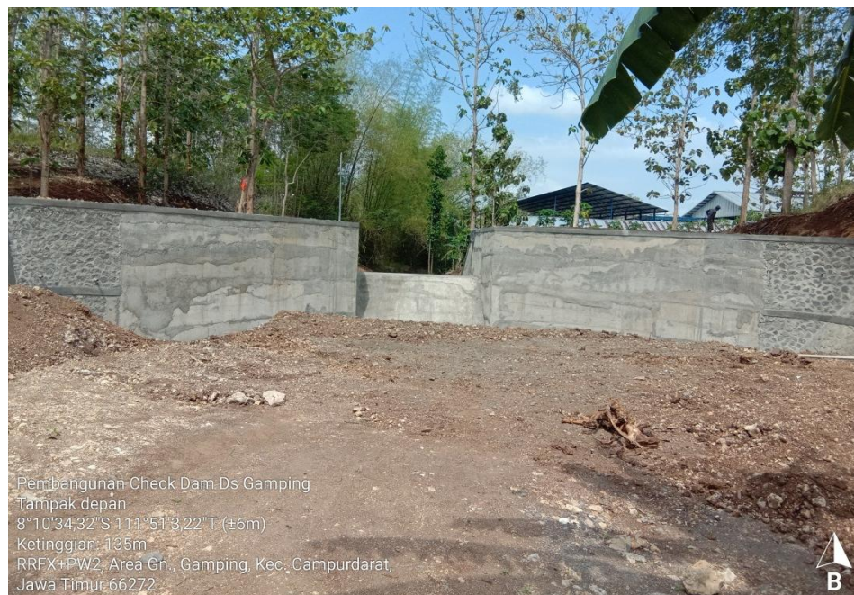
Gambar 1.1. Bangunan check dam Gamping tampak bagian hulu
