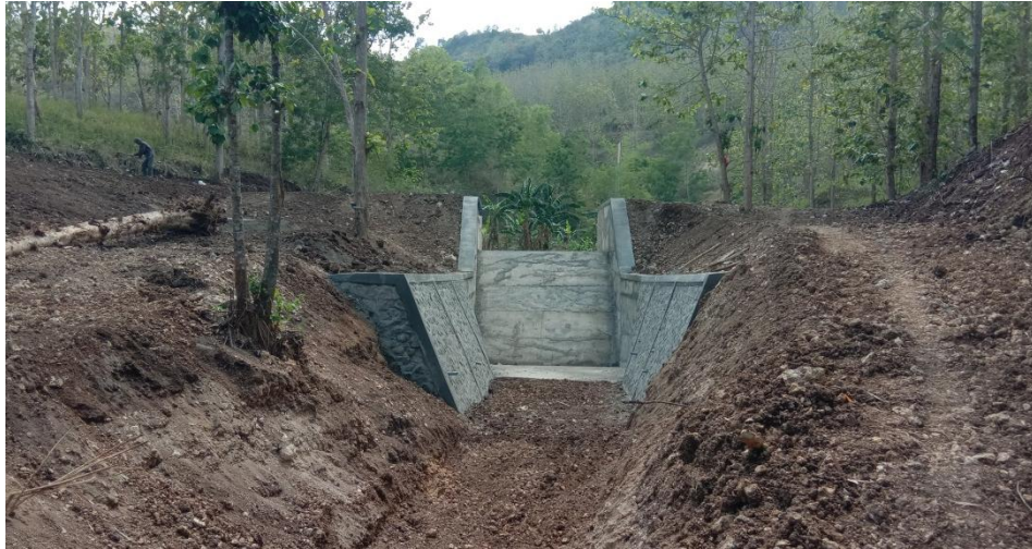
Gambar 1.2. Bangunan check dam Gamping tampak bagian hilir Sumber: Data Dinas PUPR Kabupaten Tulungagung (2025)
