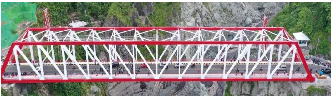
Gambar 1.3 Gambar Jembatan Besuk Kobo'an
