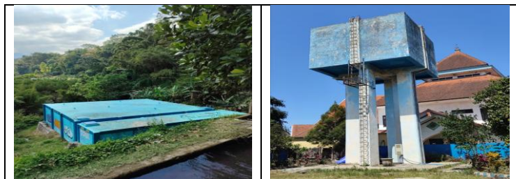
Gambar 4. 5 Kondisi Reservoir dan Tandon
