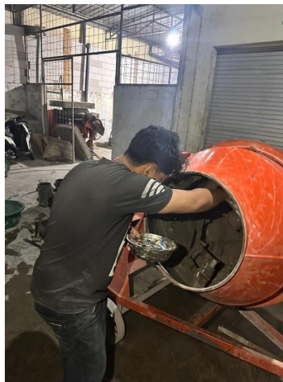
Gambar 4. 26 Pencampuran Material Sumber: (Dokumentasi Pribadi)
