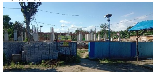
Gambar 2. Proyek Pembangunan Gedung Muhammadiyah Center Kabupaten Blitar Sumber: Dokumentasi Proyek (2026)
