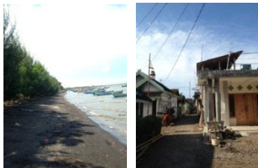
Gambar 4.3 Kondisi Eksisting Kawasan Rawan Bencana Banjir Rob
