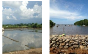
Gambar 4.4 Kondisi Eksisting Kawasan Rawan Bencana Banjir Rob
