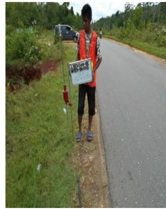
Jalan Sentani - Warumbaim - Genyem STA 62+000
