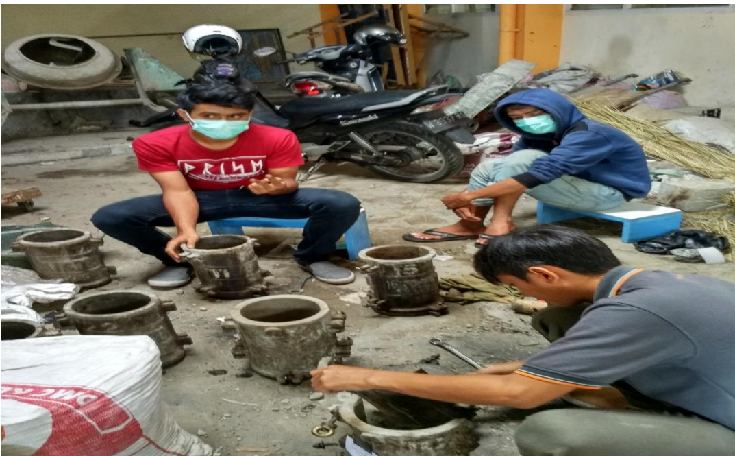
Proses persiapan begisting untuk proses pengecoran
