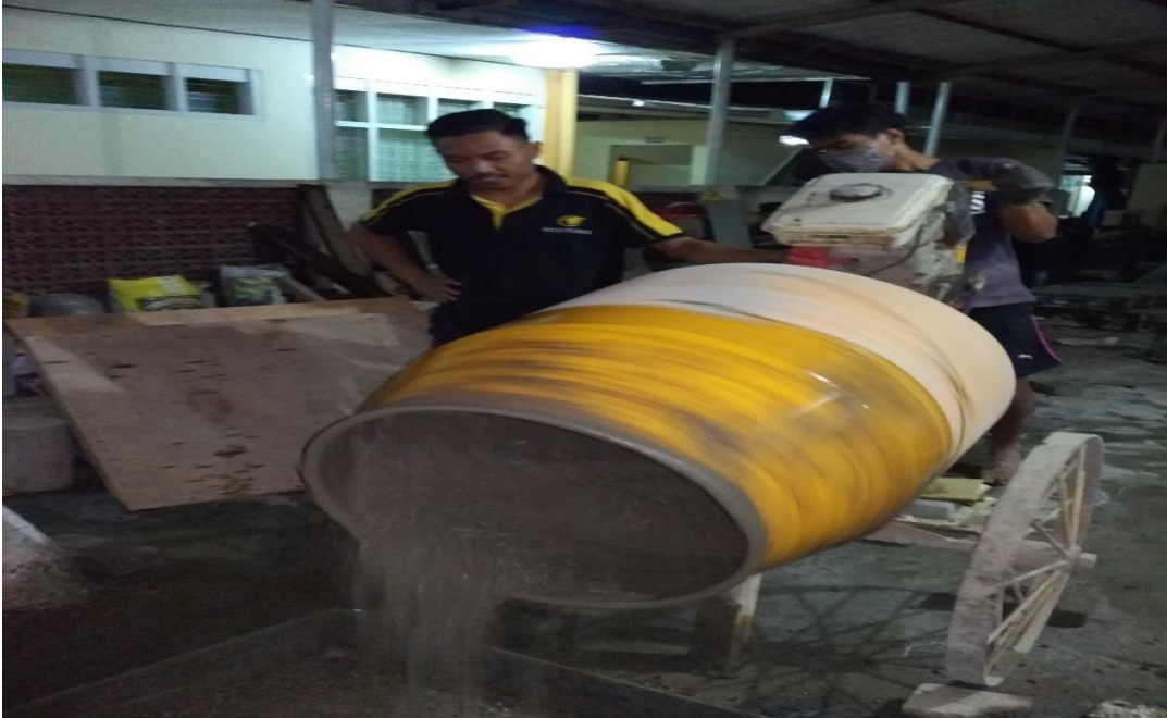
Proses menuang bahan yang sudah di campur menggunakan mesin pengaduk
