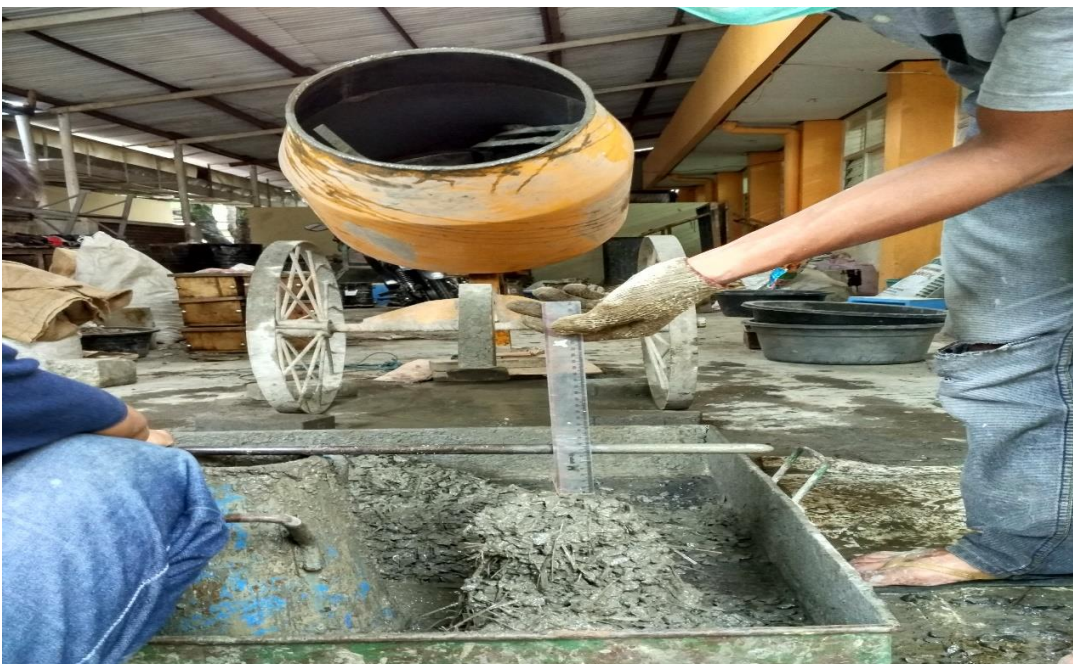
Proses menghitung nilai slump pada adukan beton sebelum di tuang kebegisting
