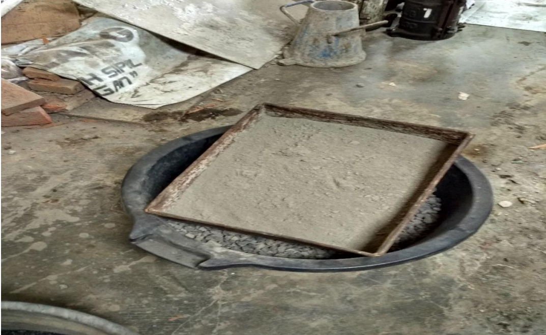
Proses persiapan bahan untuk proses pengecoran
