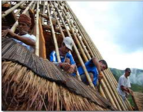
Gambar 2.6 Pemasangan atap menggunakan alang – alang (Sumber : wahyuadnyana.wordpress.com )
