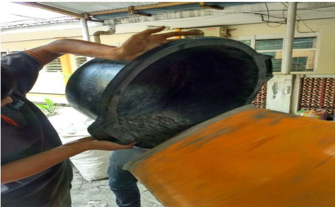
Proses pengecoran memasukkan bahan agregat
