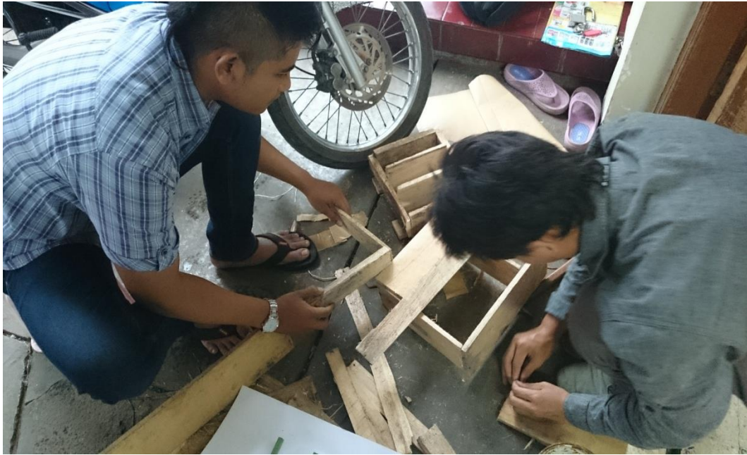
PEMBUATAN BEKISTING KUBUS
