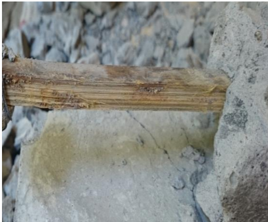
Gambar 5.4. Bambu (BP) setelah beton mengering
