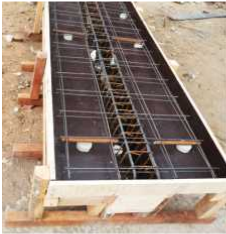
Benda uji yang akan di cor
