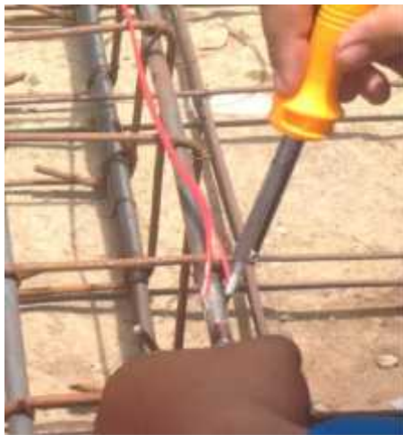
Pemasangan Strain Gauges
