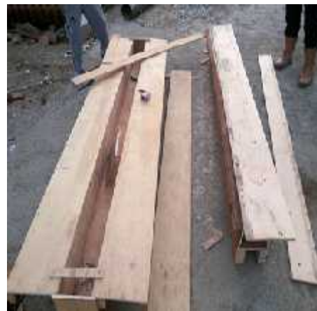
Pekerjaan pembuatan begisting
