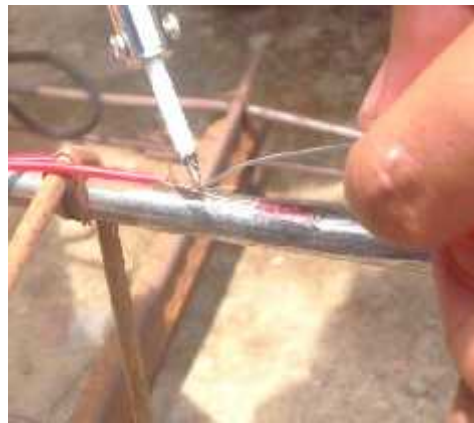
Pemasangan Strain Gauges
