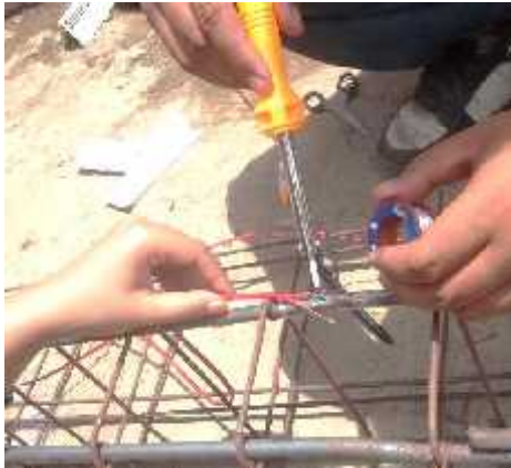
Pemasangan Strain Gauges
