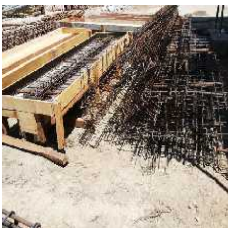
Benda uji yang akan di cor
