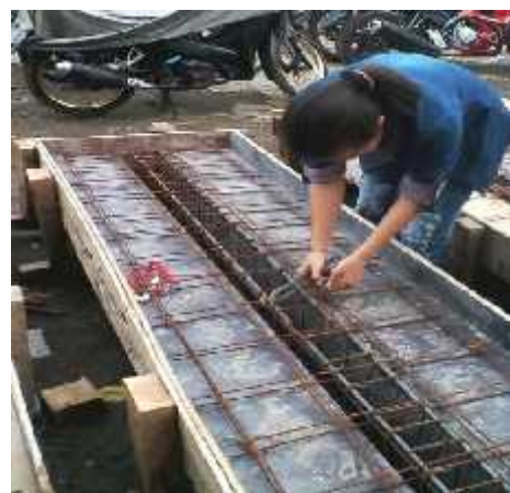
Benda uji yang akan di cor
