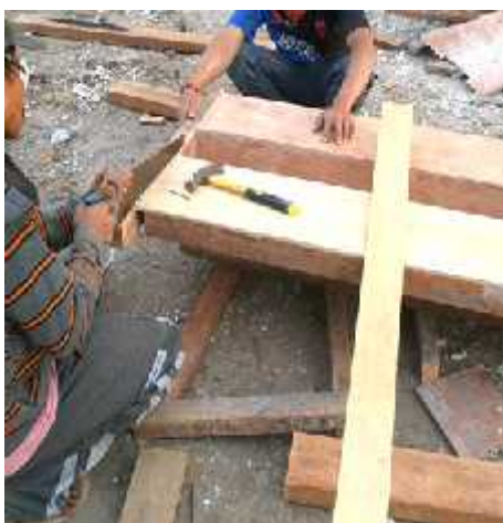
Pekerjaan pembuatan begisting
