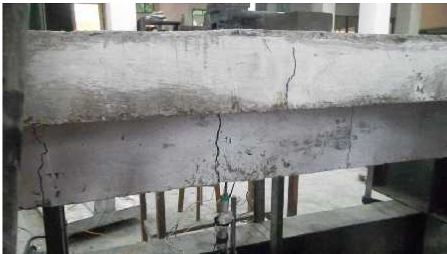
Gambar 4.2 Retak Yang Terjadi Pada Balok T Tanpa Sambungan A (BTS-A)
