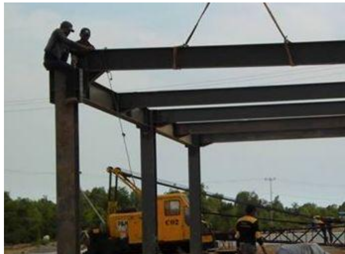
Gambar 4.6 Pemasangan Balok - Kolom
