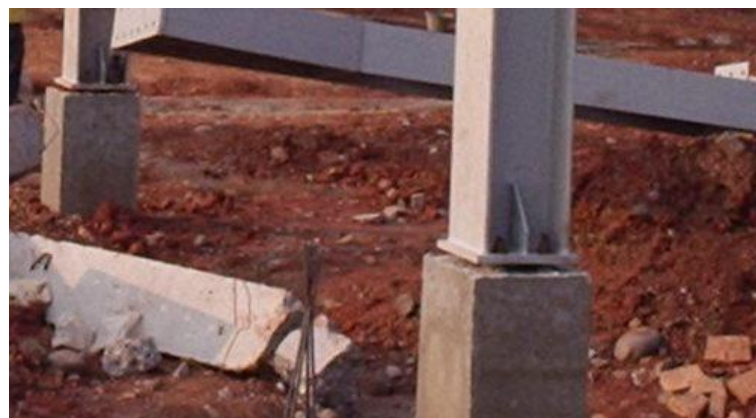
Gambar 4.5 Pemasangan Kolom
