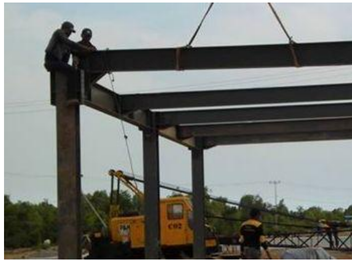
Gambar 4.6 Pemasangan Balok - Kolom
