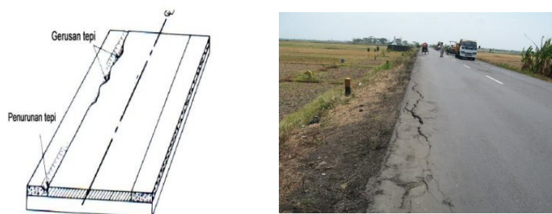
Gambar 2.28 Edge Cracking
