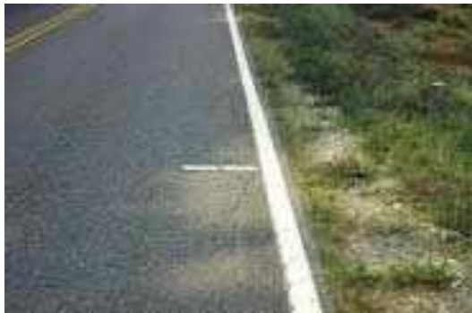
Gambar 2.3 Retak Pinggir
