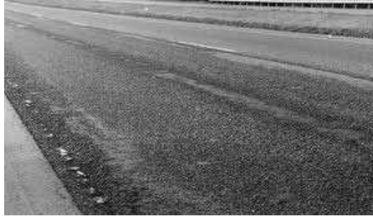
Gambar 2.14 Pelepasan Butiran
