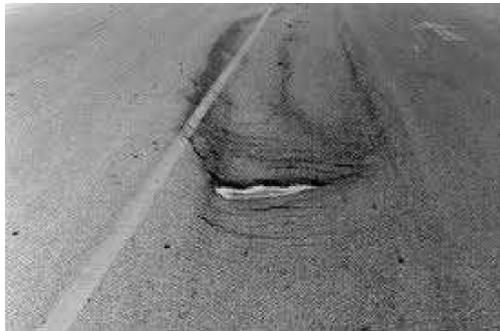
Gambar 2.8 Retak Slip
