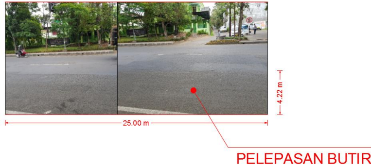
Gambar 4.27 Hasil Pengukuran Kerusakan Pelepasan Butir pada Segment 2 Jl. Panji Suroso
