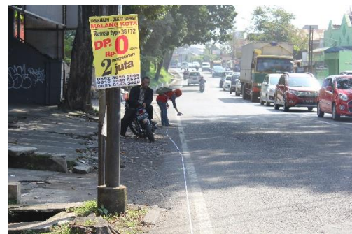
Gambar F23 Penandaan Segmen dengan Pylox
