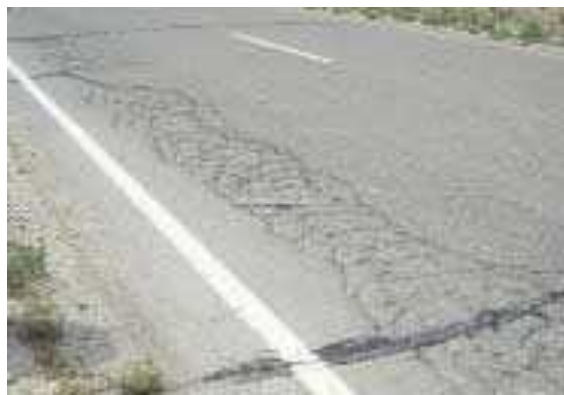
Gambar 2.2 Retak Kulit Buaya
