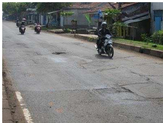
Gambar 2.7 Retak Susut
