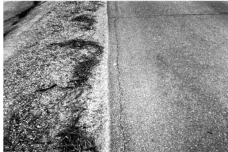
Gambar 2. 12 Retak Tepi
