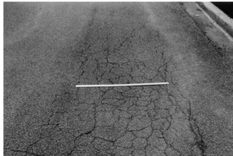
Gambar 2. 7 Retak Kulit Buaya
