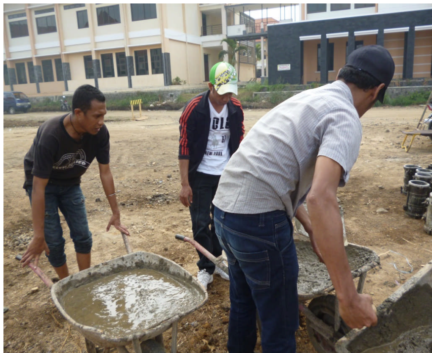
Gambar 10. Pengangkutan Campuran Beton
