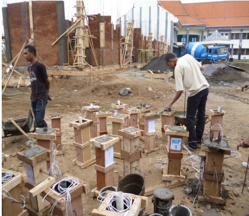
Gambar 11. Pengecoran Benda Uji
