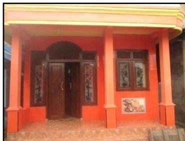
Gambar 4.1 Rumah Permanen Baik
