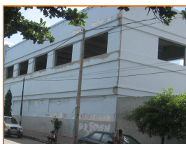
Jaringan Listrik 2 fasa, serta jaringan Telephone
