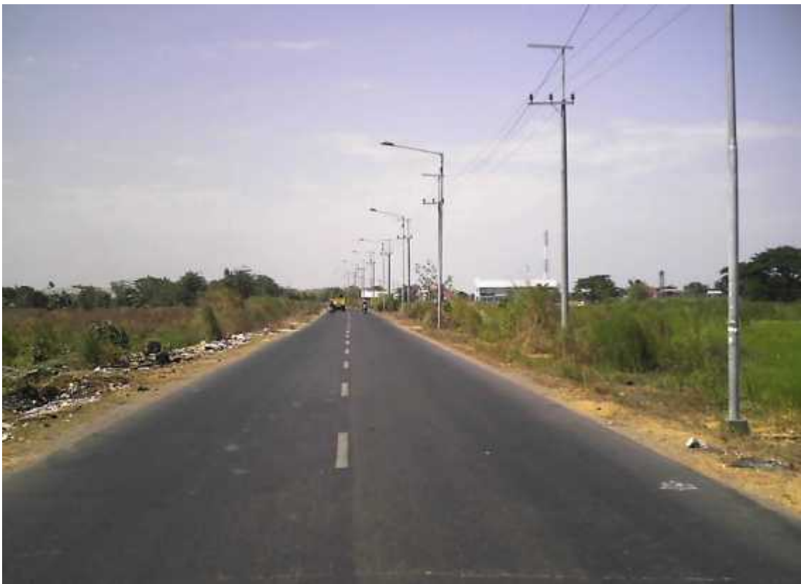
Kondisi Jalan Lingkar Timur Kabupaten Sidoarjo
