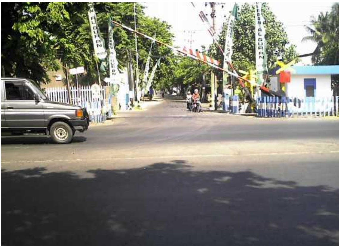
Pertigaan Akses Jalan Masuk Jalan Lingkar Timur dari Arah Surabaya
