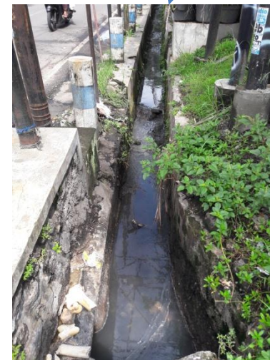
Drainase yang terdapat pada sisi selatan site
