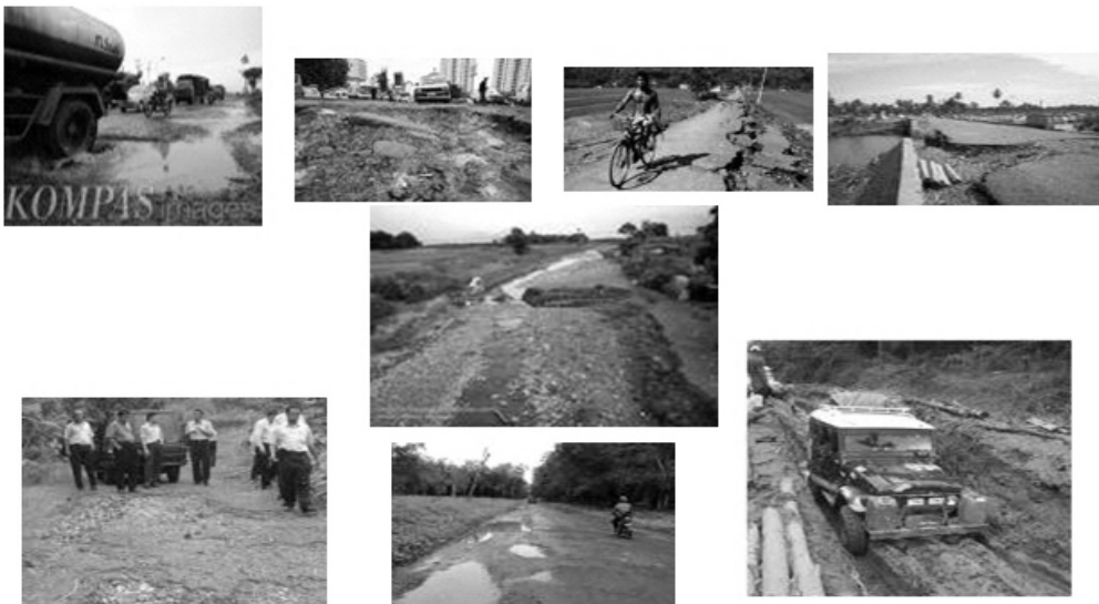
Gambar 1. Kerusakan Jalan Akibat Bencana Alam (sumber: Kompas)
