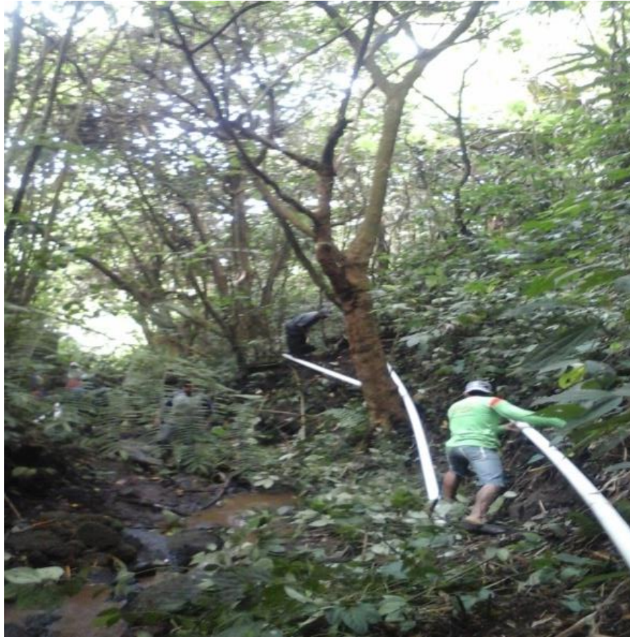
Gambar 2. Pelaksanaan Pemasangan Pipa Transmisi
