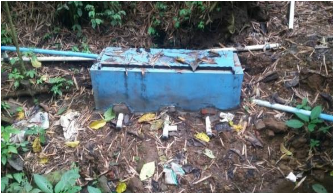
Gambar 5. Bangunan Broncaptering I
