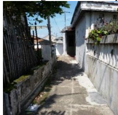
Gambar 4. 2 Kondisi Jalan Lingkungan di RW 8 Sumber : Hasil Survey, 2017
