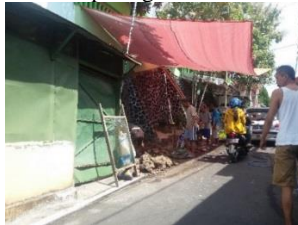
Gambar 4. 11 Gotong Royong Memperbaiki Drainase dan Pembuatan RTH Sumber : Hasil Survey, 2017
