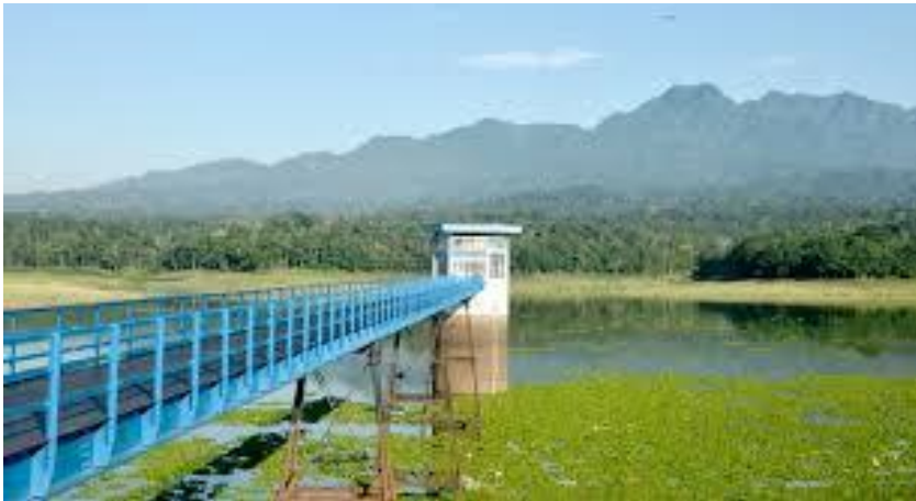
Gambar 5. Menara Pengambilan Air
