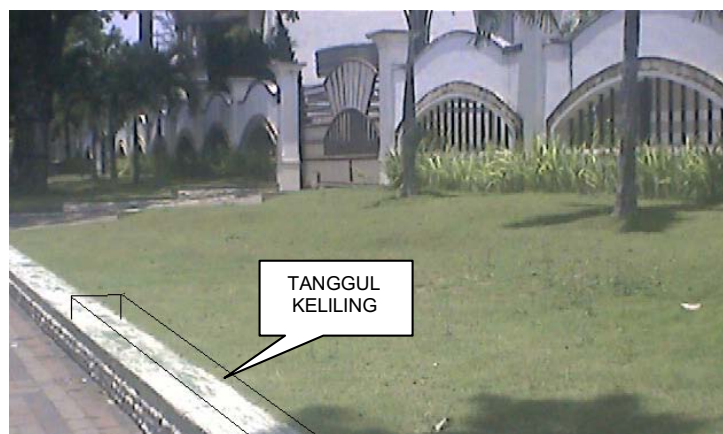
Gambar 6. Tanggul Keliling Penentu Volume Tampungan
