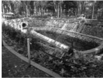
Gambar 5. Kondisi Kolam Resapan Yang Ada Di Hutan Malabar
