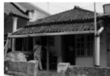
Gambar 2 Kondisi fisik rumah penduduk
