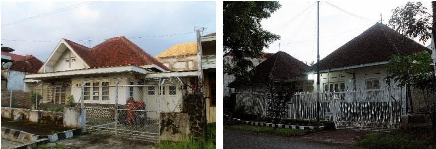
Gambar 2.4 Perumahan di Jalan Kalimantan, Kec. Klojen Kota Malang (Sumber: dokumen pribadi)
