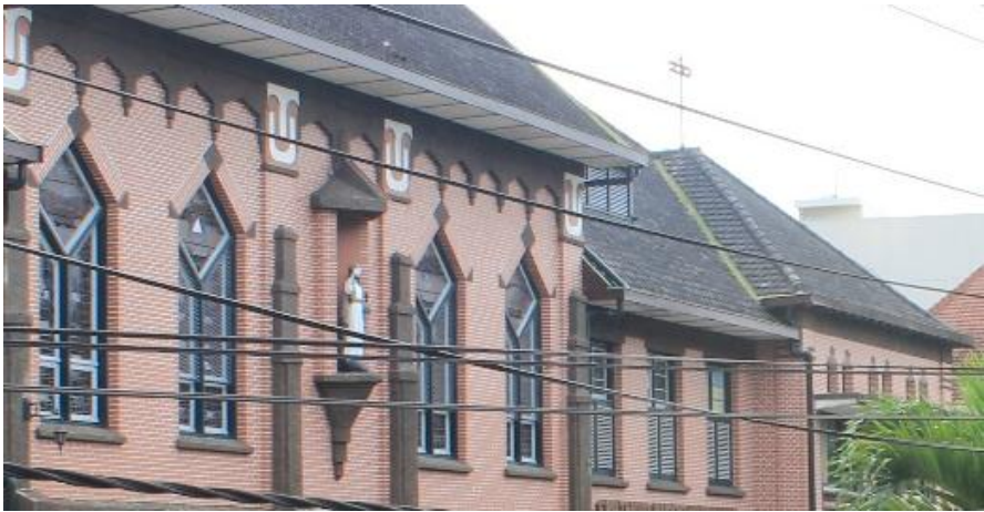
Gambar 2.7. Gedung sekolah Freteran di jalan Jaksa Agung Suprpto (Sumber: dokumen pribadi, 2015)
