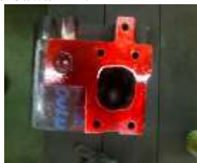
Gambar 21 Foto permukaan cylinder head setelah diberi penetrant
