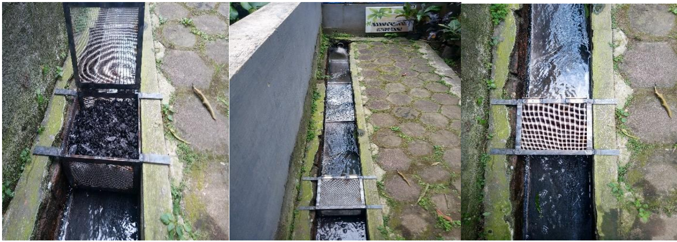
Gambar 3 : Kotak filter sudah terpasang pada lokasi hilir saluran pembuang.
