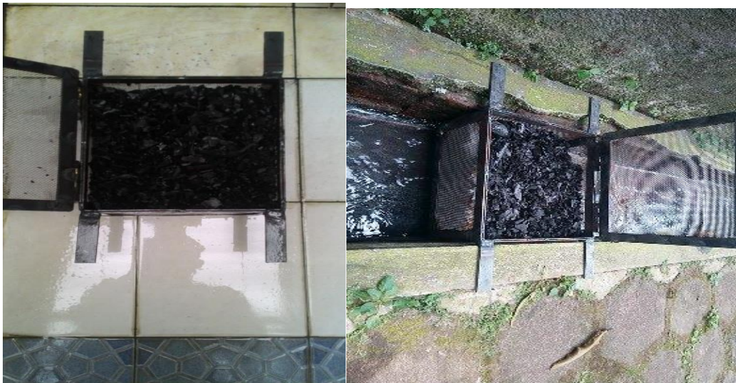
Gambar 2 : Kotak sudah terpasang arang batok kelapa
