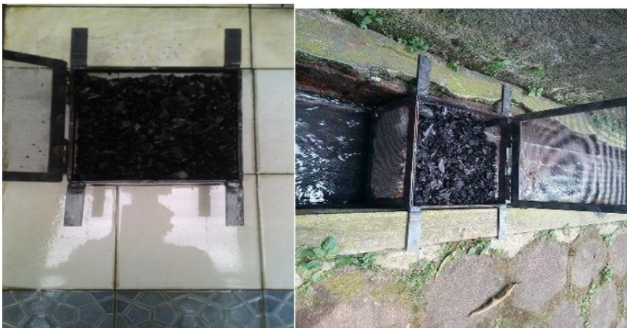
Gambar 2 : Kotak sudah terpasang arang batok kelapa
