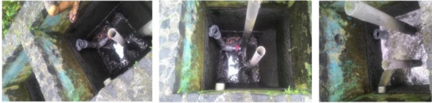
f. Proses pemasangan
