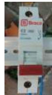
Gambar 19. Tampilan Trip *Circuit Breaker* Ketika Mendeteksi Arus Gangguan
