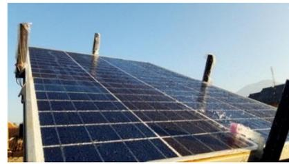
Gambar 4.15 Pembersih solar sel dengan air
