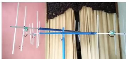
Gambar 9. Hasil Antenna Yagi Yang Sudah Terpasang
